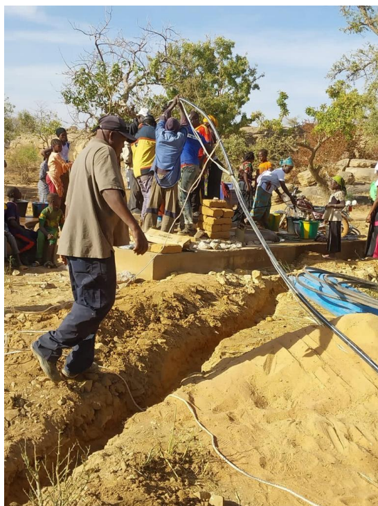
Creusement des tranchées par les hommes pour passer les câbles, scellement et pose du socle à Kansongo
