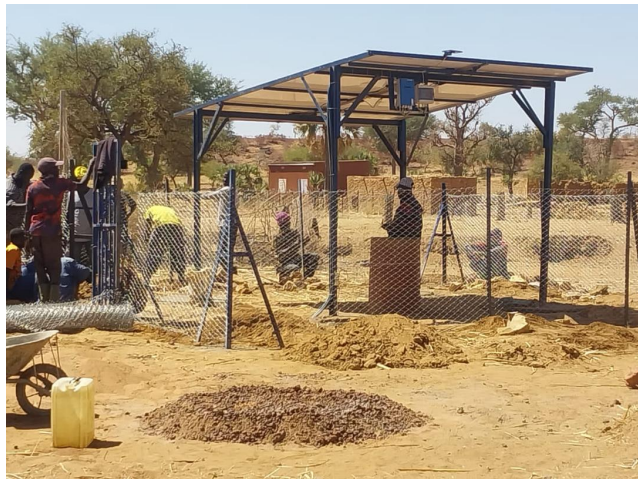
Nombo, Ensemble Cébazat, Mise en place des bornes fontaines scellement du socle du château d'eau et mise en place des panneaux solaires
